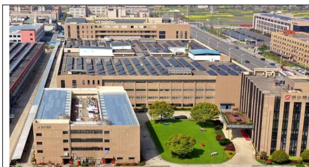
公司屋顶太阳能（光伏）
