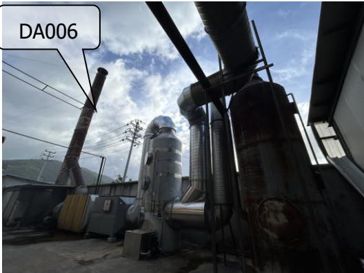
六分厂西侧：水喷淋+脱水+活性炭吸附装置及 DA006
