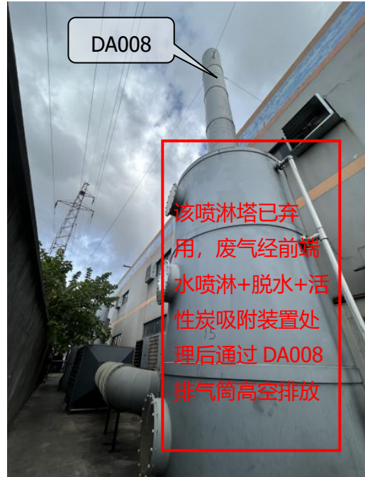
二分厂北侧：水喷淋+脱水+活性炭吸附装置及 DA008
