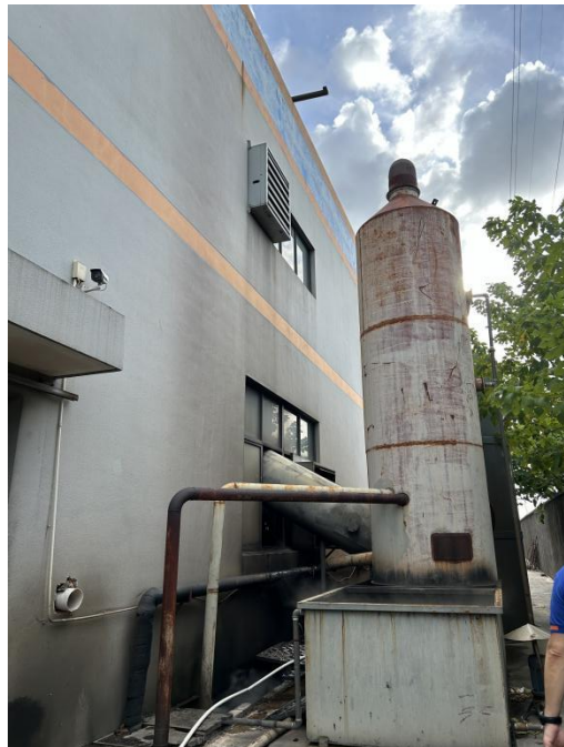
二分厂北侧：水喷淋+脱水+活性炭吸附装置及 DA008
