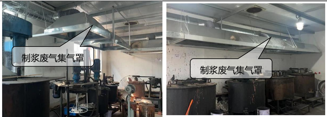
制浆废气集气罩收集
