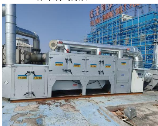
涂布废气甲苯回收装置：冷凝+活性炭吸附+脱附-冷凝回收+催化燃烧
