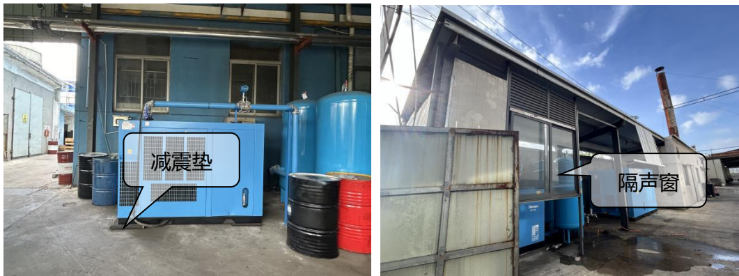
图 3-3 减振隔声措施
