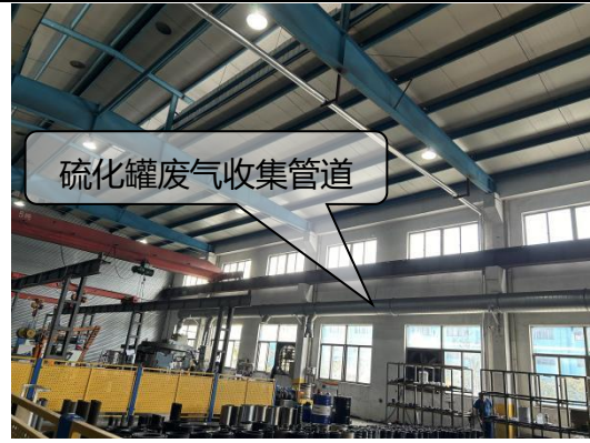
硫化罐废气收集管道
