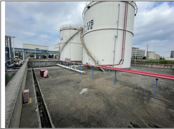
苯酐原料罐区
