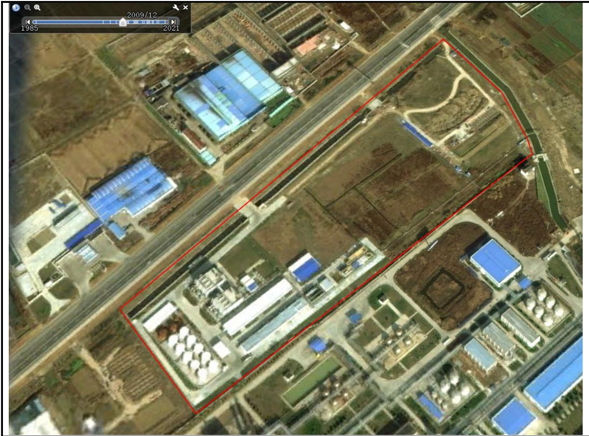
图2.3-3浙江伟博化工科技有限公司地块2009年影像图
