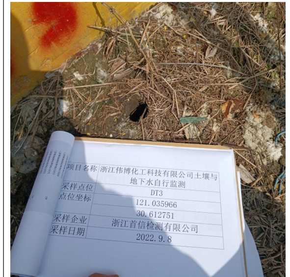
照片3： 完成钻 孔
