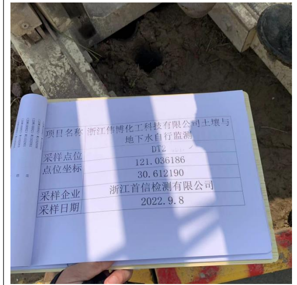
照片3： 完成钻孔
