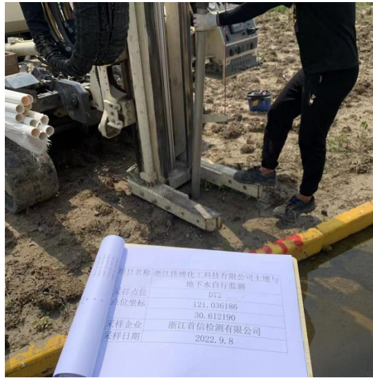
照片2： 进行钻孔
