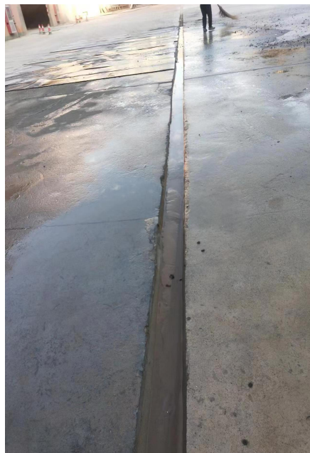
泥浆废水收集槽
