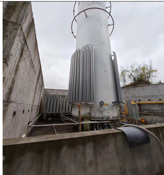
天然气储罐围堰
