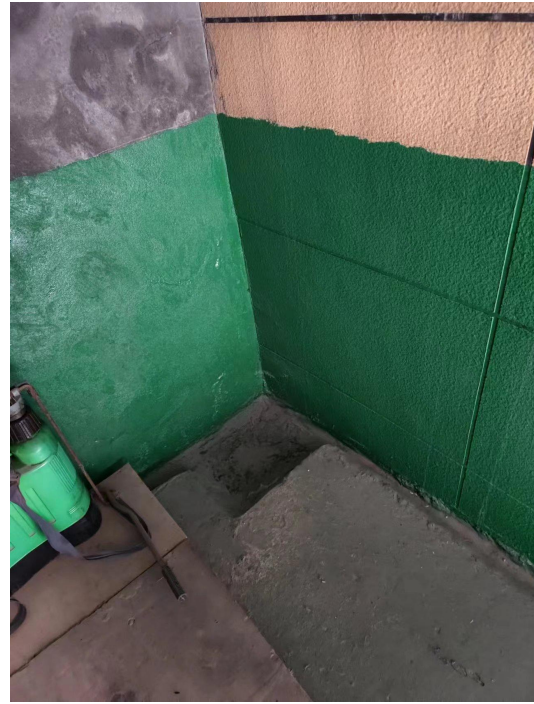
现有 10m 3 危废暂存库照片
