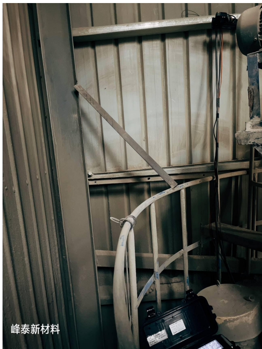
储料罐废气排放口
